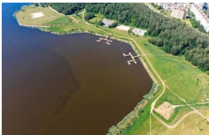
Рисунок 3.2 – Общий вид Солигорского водохранилища
